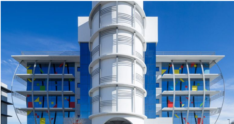
Colegio Reggio Explora. Situado en el Edificio Talos. Calle Quitanapalla 10.
